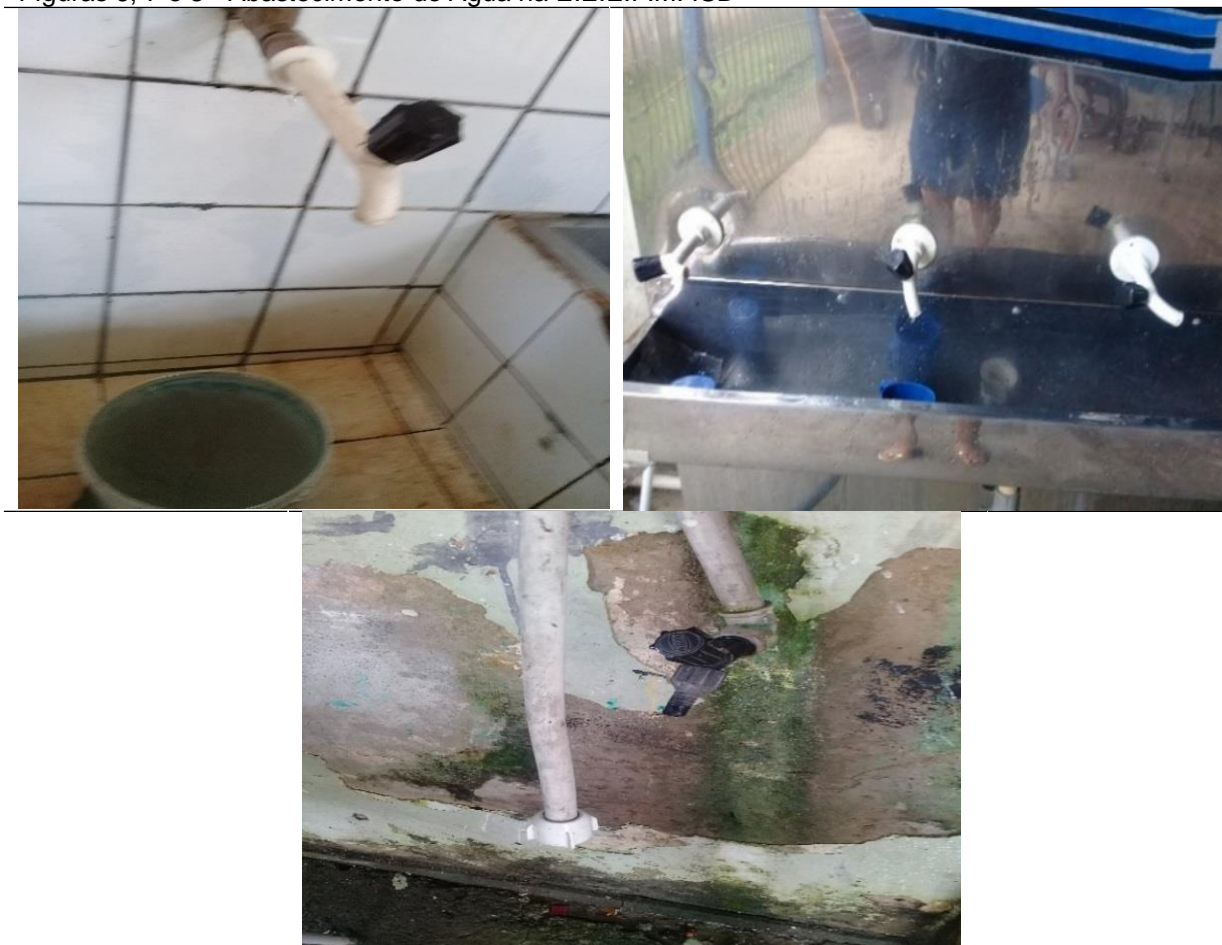
Figuras 6, 7 e 8 - Abastecimento de Água na E.E.E.F.M. ISD
