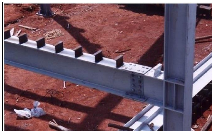
Figura 2.8 - Conector U soldado às vigas em um canteiro de obras. Fonte: (BARBOSA, 2016)
