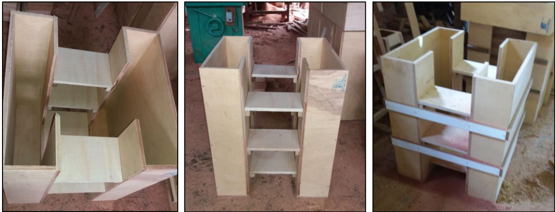
Figura 3.27 – Execução das formas.
