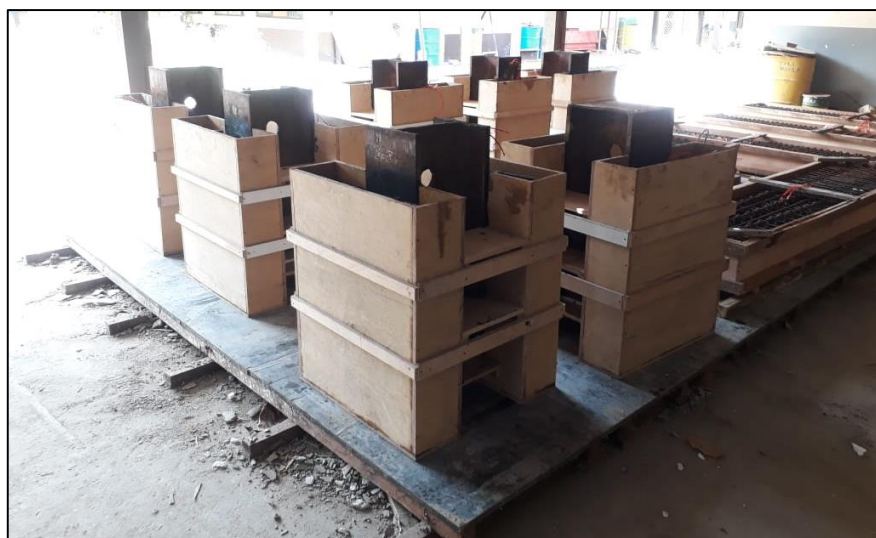
Figura 3.33 – Espécimes nas formas e prontos para concretagem
