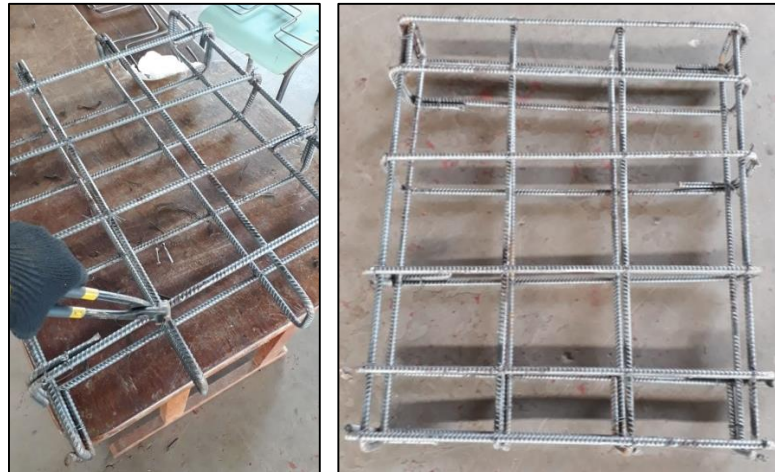
Figura 3.29 - Armadura das lajes
