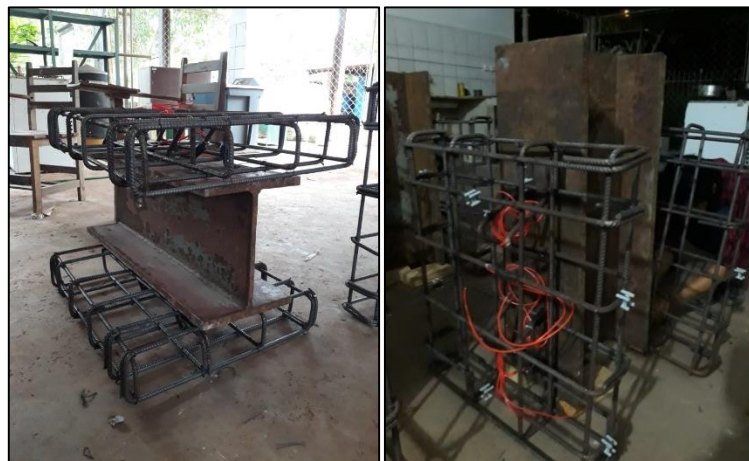
Figura 3.30 – (A) Armadura em posicionamento e (B) Espécime TI preparados
