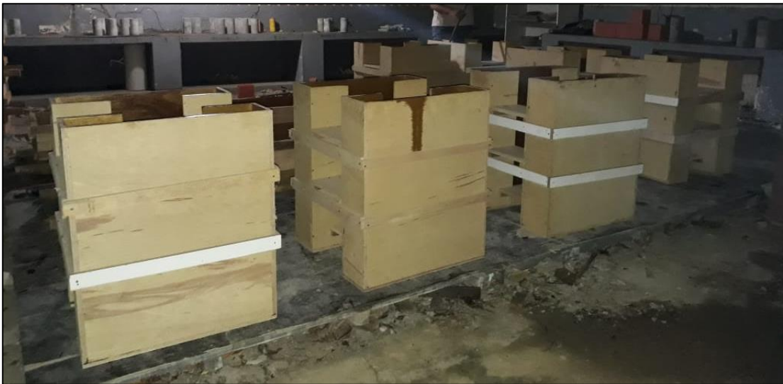
Figura 3.28 – Formas executadas e preparas com desmoldante.
