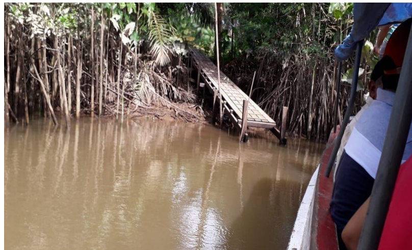
Figura 10. Ponte de acesso a estação de alevinagem, Comunidade Genipauba, Abaetetuba-PA.
