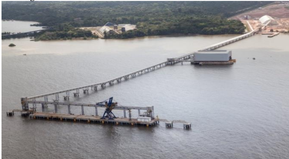
Figura 02 – Píer do TUP Hidrovias do Brasil S.A.
