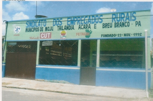
Foto atual do Prédio do Sindicato - frente
