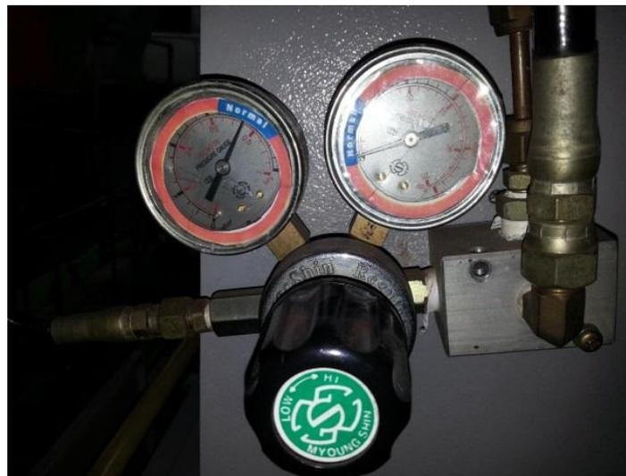
Figura 3.12 - Válvula reguladora de pressão.
