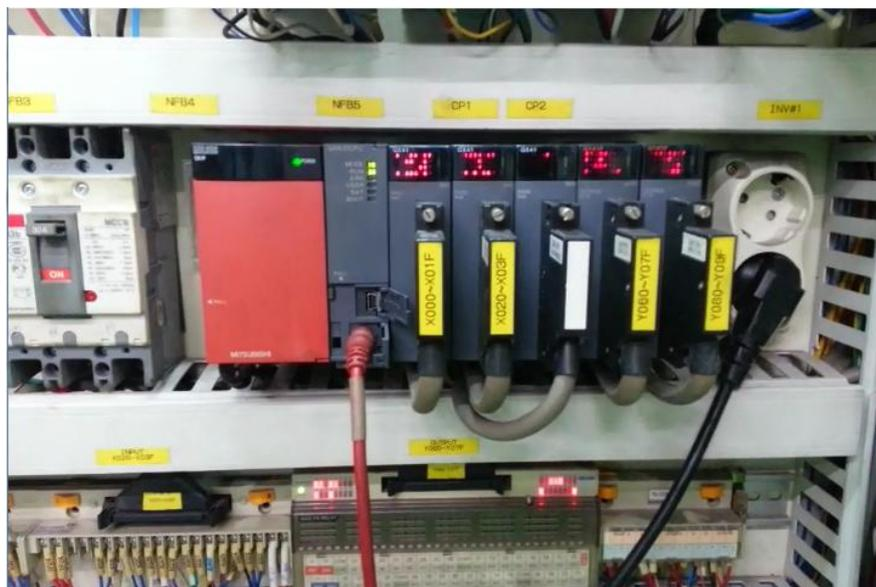
Figura 3.16 - CLP's Mitsubishi usados para programação do novo sistema de injeção.
