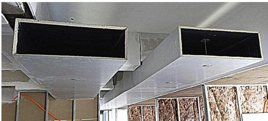
Figura 2.7 - Exemplo de ar condicionado central.
