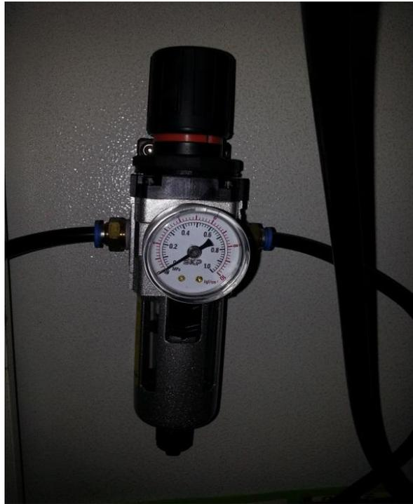
Figura 3.11 - Filtro de ar comprimido.
