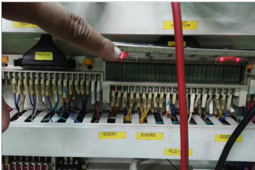
Figura 3.18 - Dispositivos de Saída usados na programação de novo sistema de injeção.
