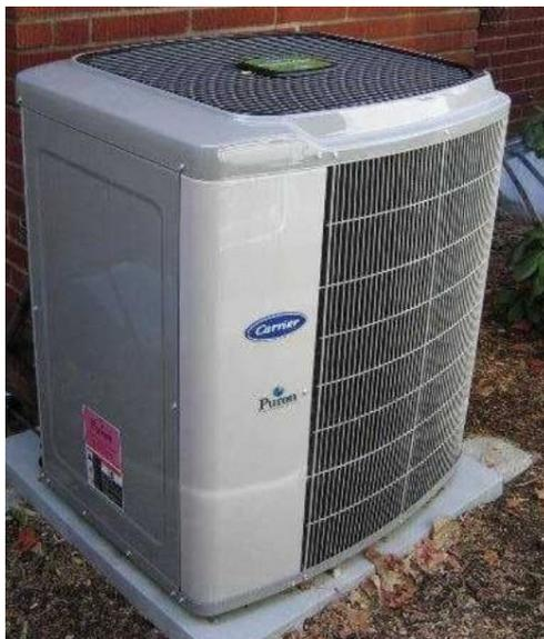
Figura 2.11 - Exemplo de bomba de calor de fontes de ar.
