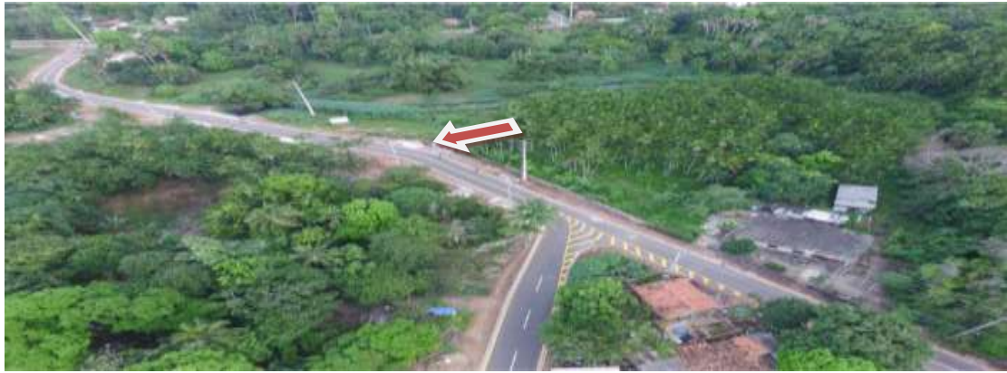
Figura 4.3 - Interligação entre os bairros Turu e Parque Vitória (Ponte Pai Inácio). FONTE: Governo do estado do Maranhão (2016).
