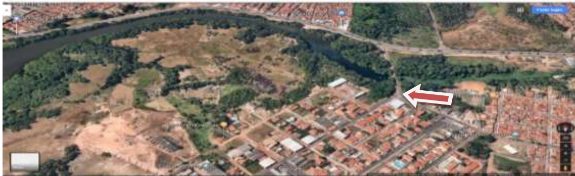
Figura 4.2 - Ponte que interliga o bairro Parque dos Nobres à cidade. FONTE: GOOGLE MAPS (2020).
