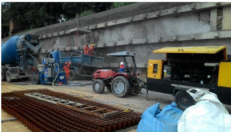
Figura 3.1 - Sistema de projeção de concreto.
