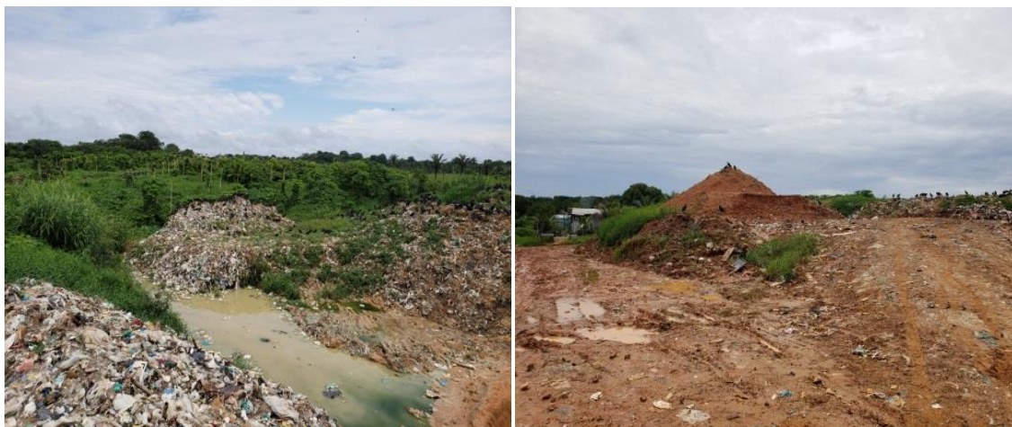
Figura 4.27 - Aterro sanitário da cidade de Tefé.
