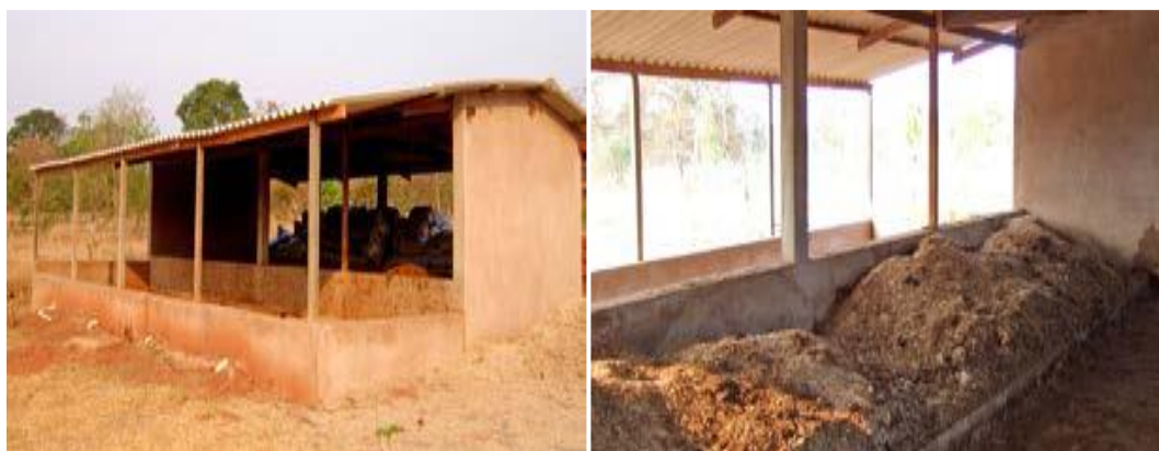
Figura 2.2 - Composteira para reciclagem de resíduos sólidos da indústria de processamento de tilápias. A) Exterior da estrutura construída para a compostagem. B) Vista interna da composteira.
