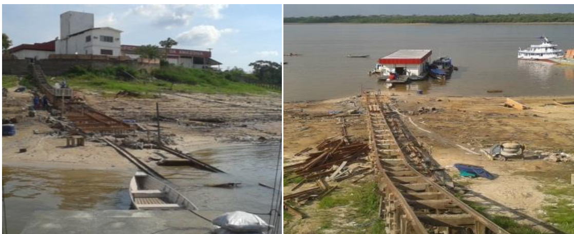
Figura 4.9 - Transporte do pescado da balsa flutuante à terra, via trilhos em carrinho de inox.
