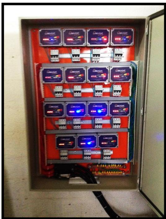
Figura 5.37 Filtros colocados no QGBT/380V.
