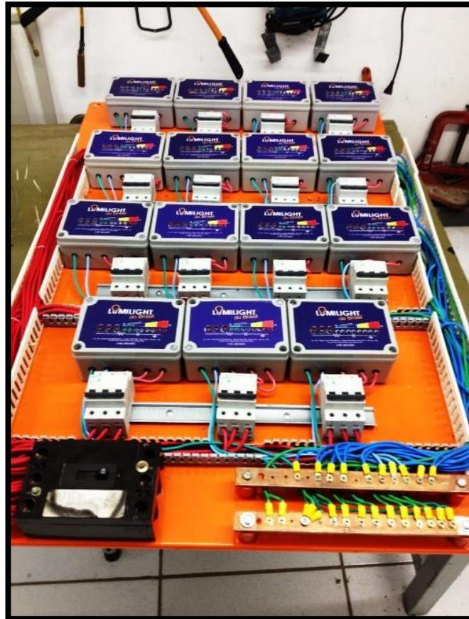
De acordo com a figura 12, é o início da montagem do quadro de comando dos filtros capacitivos na tensão de 380V, que ficará em paralelo com disjuntor de baixa tensão de 1000A Aj 0,8 In. São instalados somente 05 unidades, devidos a corrente consumida no QGBT de 380V e inferior da corrente consumida no QGBT de 220V.
