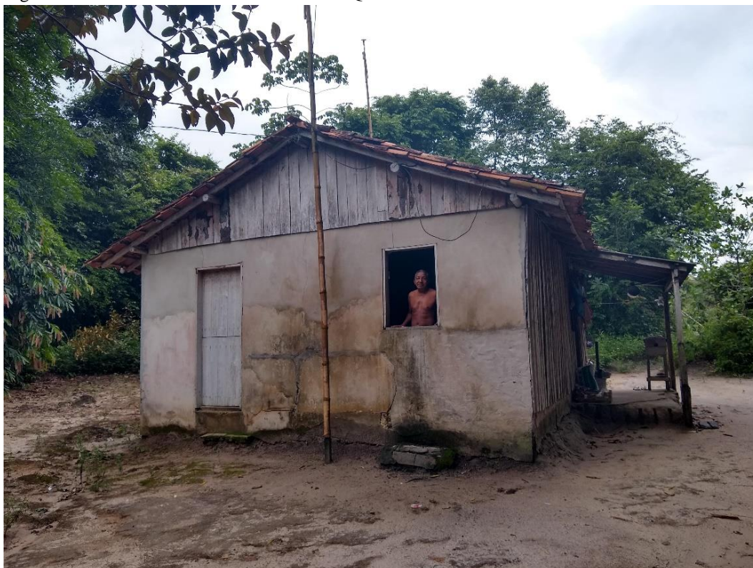
Figura 15: Residência no Sítio Livramento – Quilombo São Pedro.
