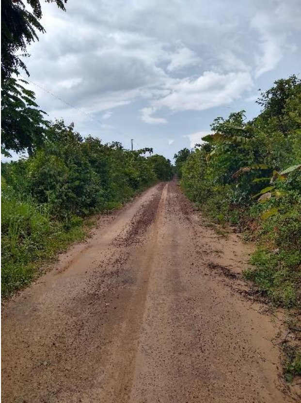
Figura 12: Estrada de acesso ao Quilombo São Pedro – Ramal Cupiuba.
