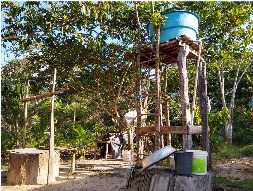
Figura 19: Exemplo de “poço de boca aberta” com bomba e caixa d’água.
