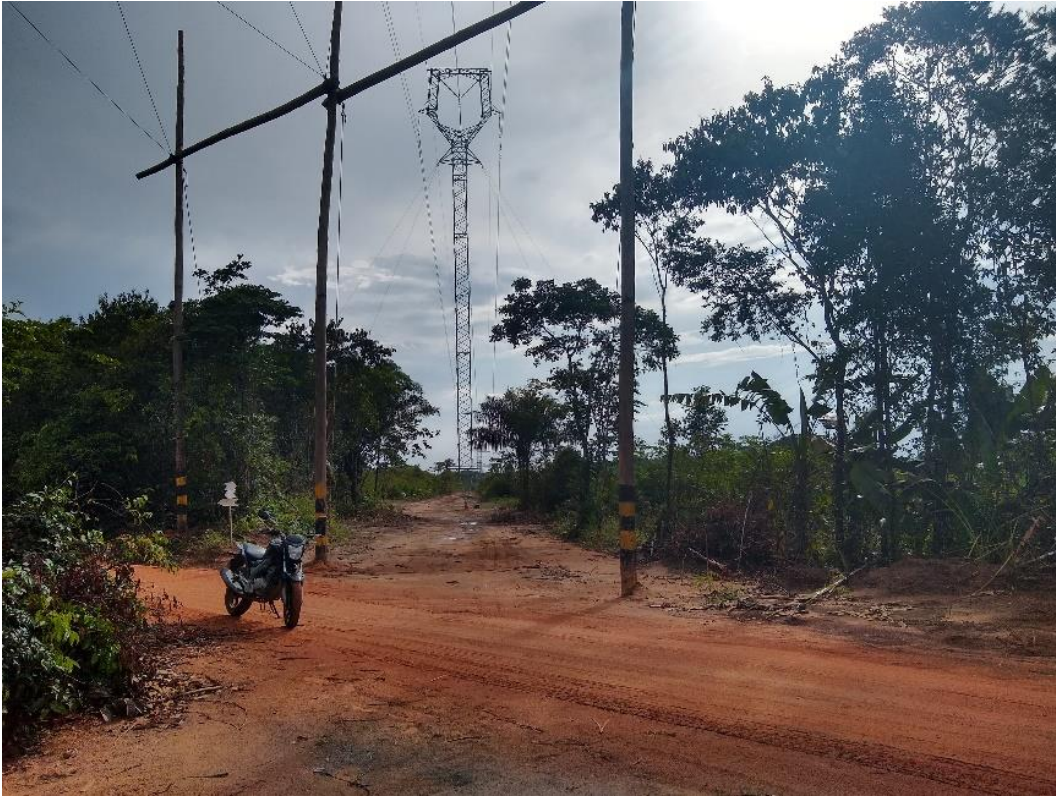
Figura 22: Construção do Linhão da Equatorial Energia próximo do Território Quilombola de São Pedro
