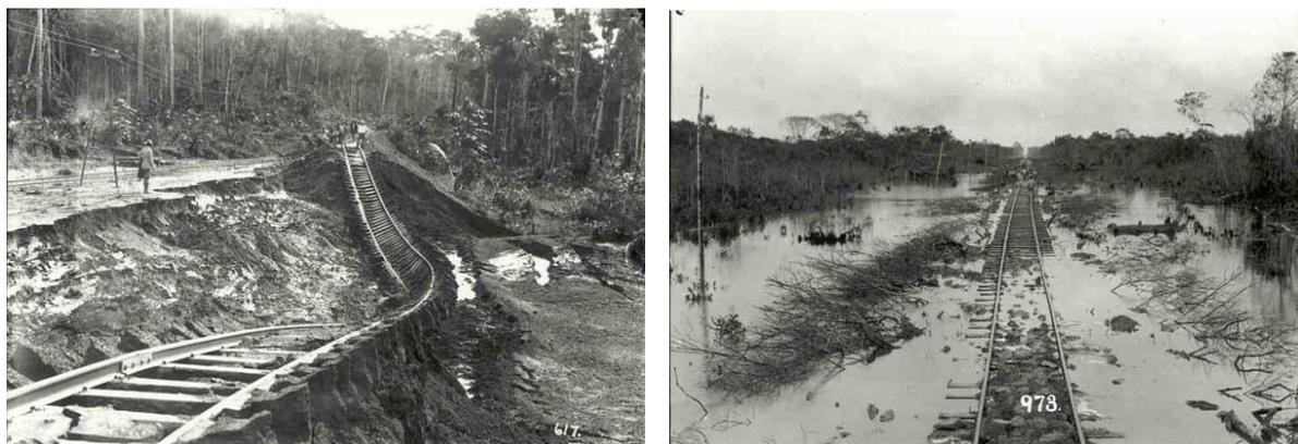
**Figura 15 - Deslizamento de trilhos provocado por chuvas (esq.) e linha inundada pela cheia do rio Madeira (dir.)**
