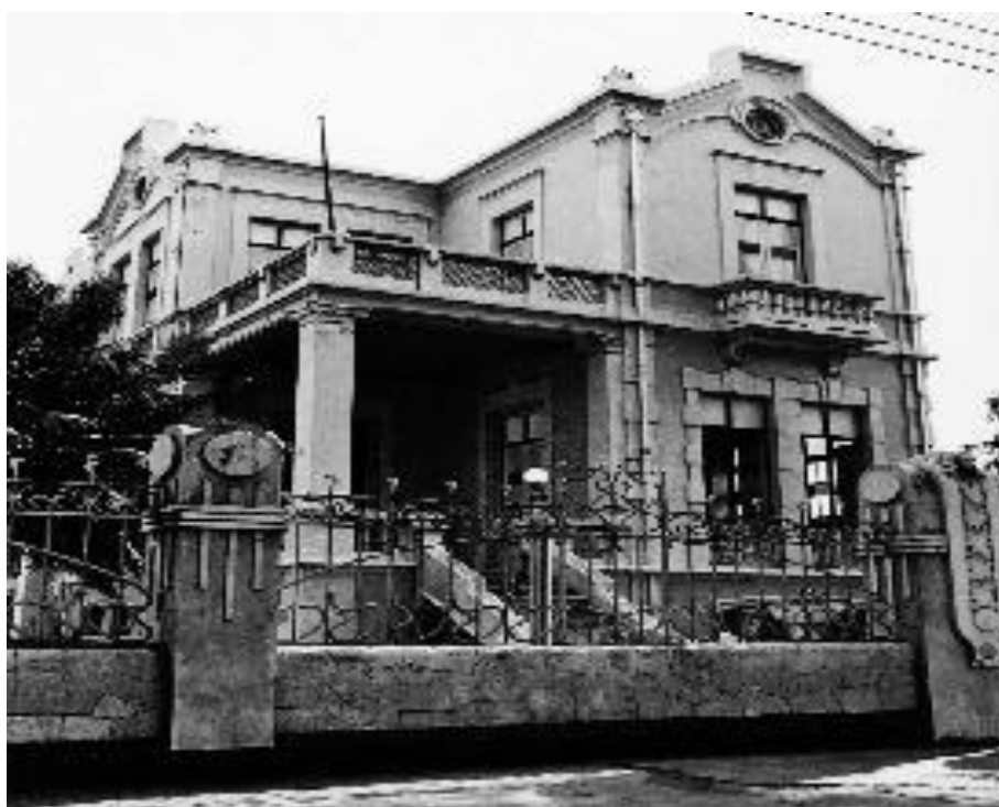
Figura 6 - Foto do prédio da Faculdade de Ciências Econômicas, Contábeis e Atuariais no Estado do Pará.
