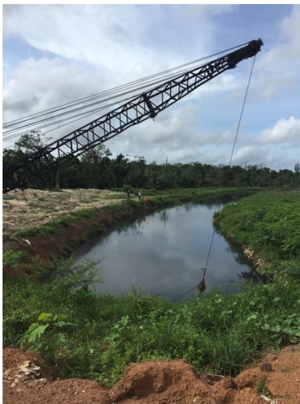
Figura 4.9 - Dragagem realizada na lagoa de deposição de chorume no Aurá Fonte: Autora da tese
