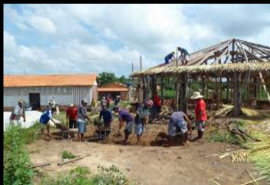
Aterro para a base da Casa Rural
