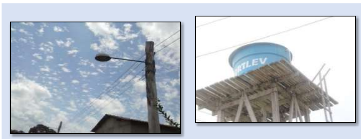
Figura 32 – Sistema de abastecimento de água e energia elétrica
