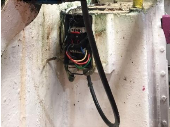
Figura 4.17 - Seccionadora quebrada.
