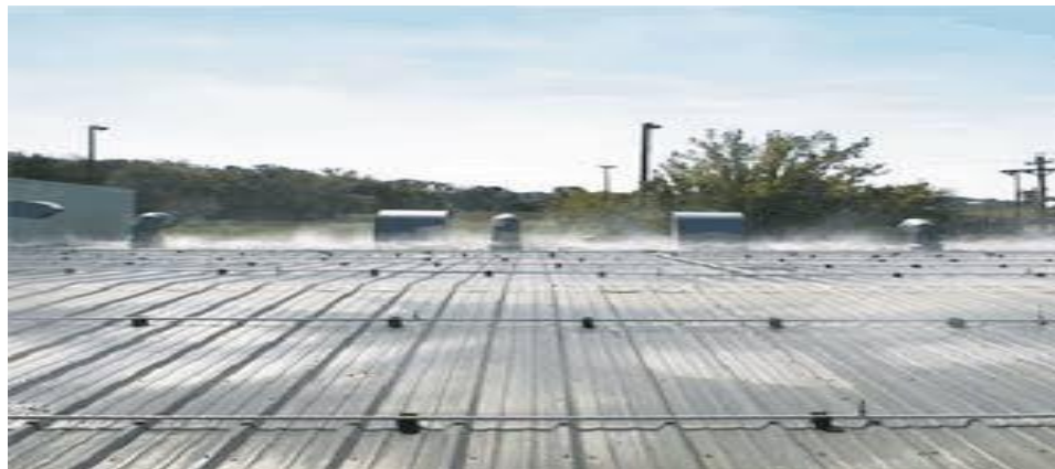
Figura 2.3 - Resfriamento de telhado com água. Fonte: SOLUÇÕES INDUSTRIAIS (2021).
