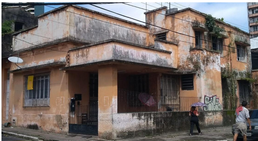
Figura 31 - Residência localizada na esquina da R. General Henrique Gurjão e Tv. Piedade
