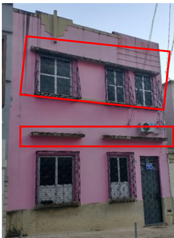
Figura 20- Edificação art déco , destaque para os frisos em cima das esquadrias.
