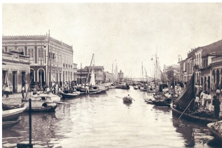
Figura 2 - Igarapé da Fábrica entre os séculos XIX/XX (atual Avenida General Magalhães)
