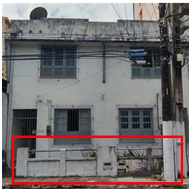
Figura 16 - Casa Isolada com guarda-corpo em ferro tubular
