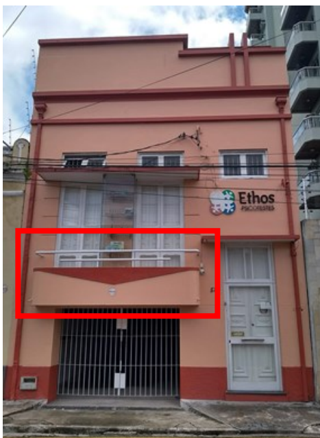
Figura 17 - Casa Isolada com balcão tubular de ferro
