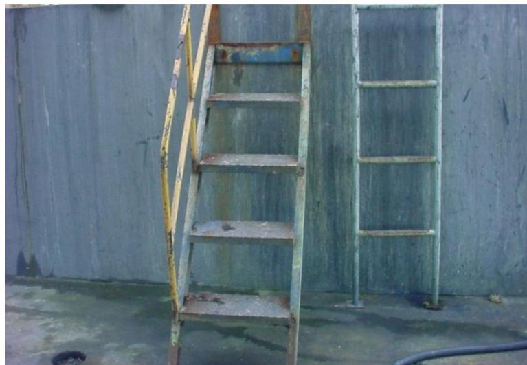
Figura 4.5 - Escadas de acesso deterioradas.
