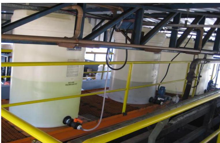
Figura 4.15 - Tanques de armazenamento dos produtos químicos.
