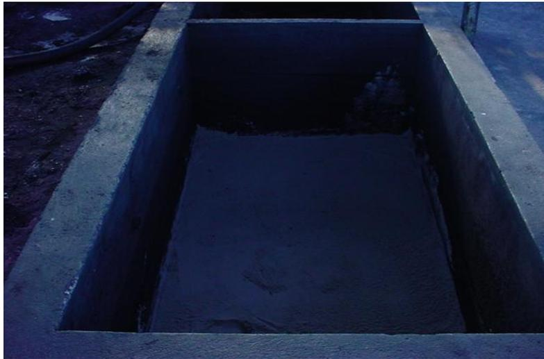
Figura 4.4 - Tanque de filtração de efluente.
