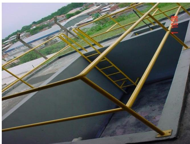
Figura 4.16- Tanques de descarte final.
