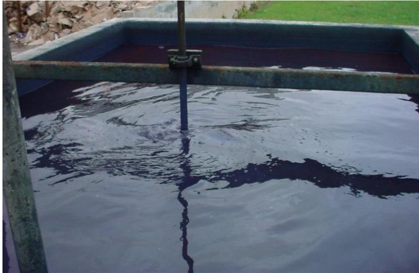
Figura 4.2 - Tanque de recebimento de efluente bruto.
