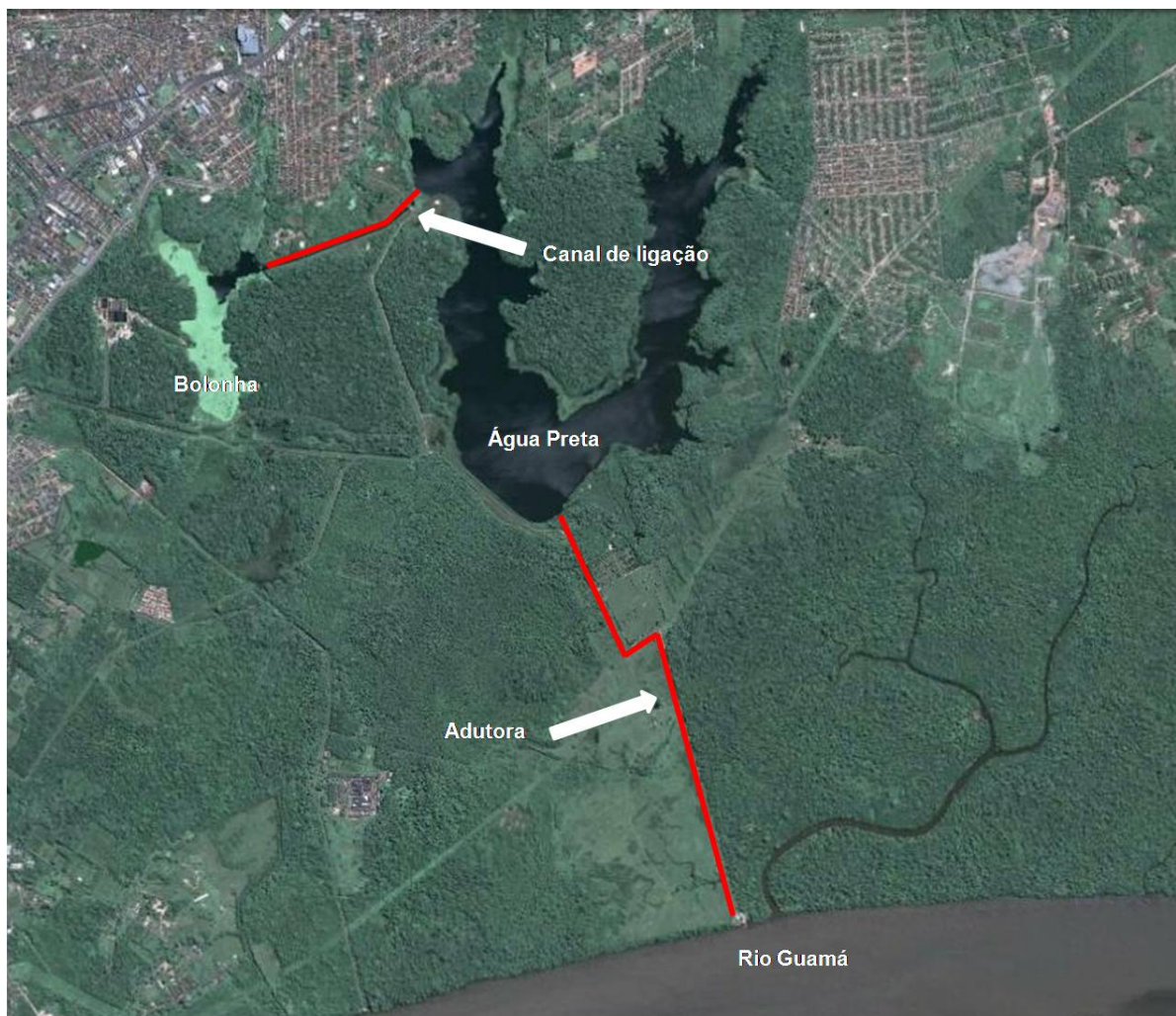
Figura 7- Fotografia de satélite do Sistema de captação de água superficial da RMB. Fonte: Google Earth, [2010].
