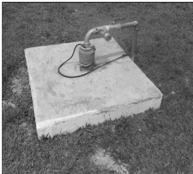
Figura 6. Local de Amostragem de Poço Barreiras, observar a boa construção do mesmo, assim impedindo o *input* de contaminantes.
