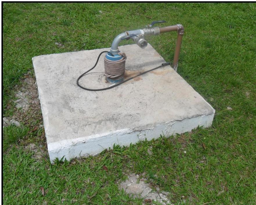
Figura 8 – Local de Amostragem de Poço Barreiras, observar a boa construção do mesmo, assim impedindo o *input* de contaminantes.
