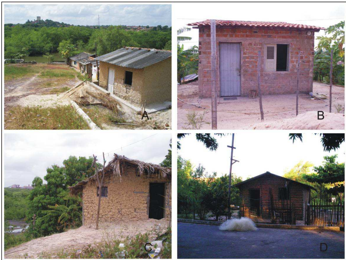
Figura 5.43: Infra-estrutura das casas de pescadores, em geral de taipo ou alvenaria sem revestimento. (A) e (B) Bairro Anjo da Guarda (Grancharia); (C) Bairro de Mauro Fecury II; (D): bairro Alto da Esperança (Tamancão).
