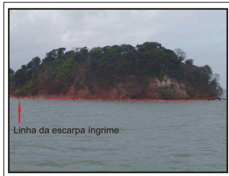
Figura 5.30: Aspecto das escarpas expostas (ISA 3B) na Ilha de Fora, em frente ao Porto de Itaqui (Foto: Pedro Walfir, 2005)
