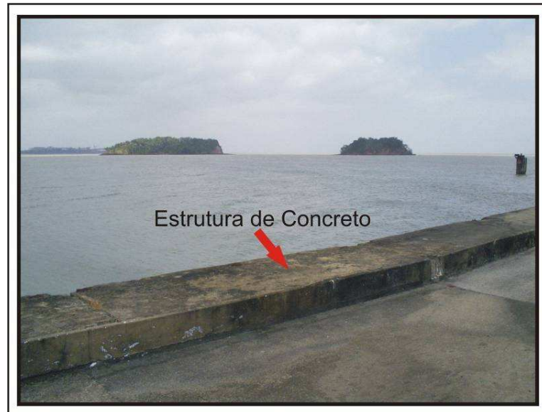
Figura 5.33: Píer (ISA 1B) de acesso ao Ferry-Boat ..
