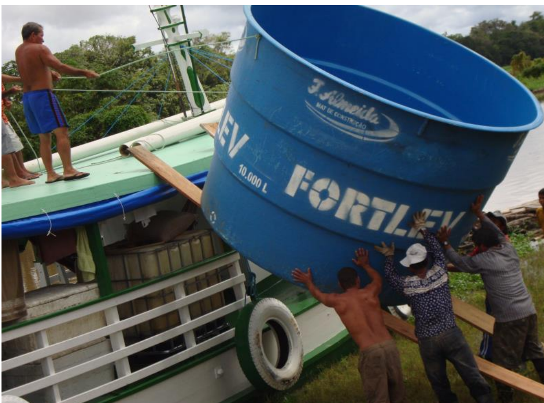
Figura 21: Desembarque do equipamento da TS na comunidade
