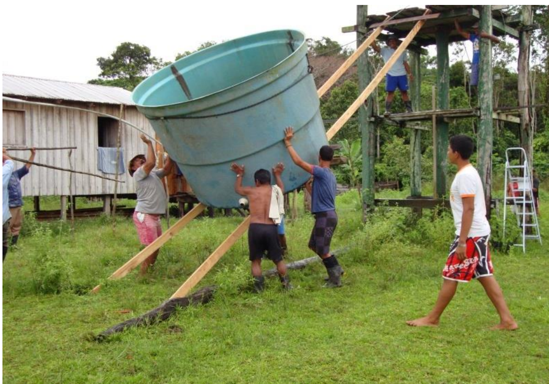
Figura 25: Esforço comunitário para elevação da caixa d'água até a torre de sustentação e distribuição da água.
