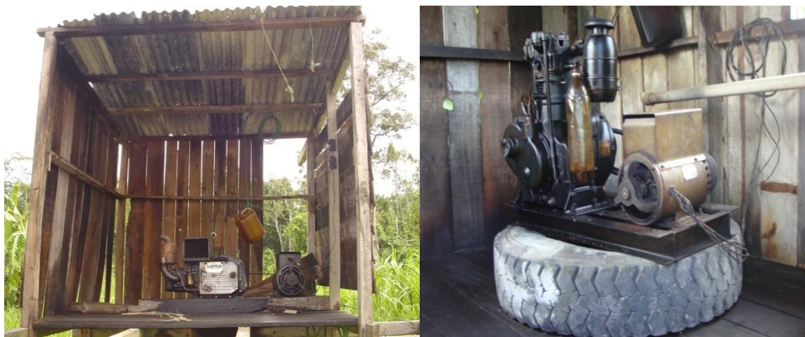
Figura 6: Tipos de motor a diesel usados nas comunidades rurais da RDSM e RDSA. Fonte: Edila Moura, 2008.
