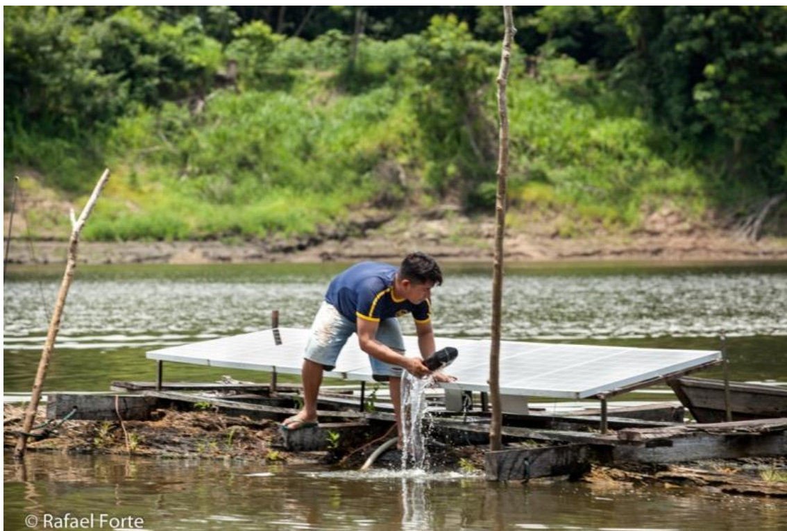
Figura 26: Placas solares instaladas sobre a base flutuante no rio - instalação e manutenção da comunidade
