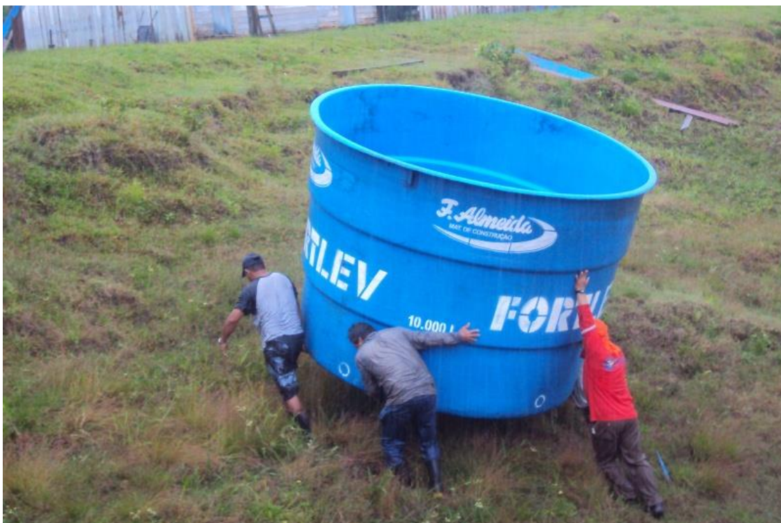
Figura 22: Condução do reservatório para o local de instalação
