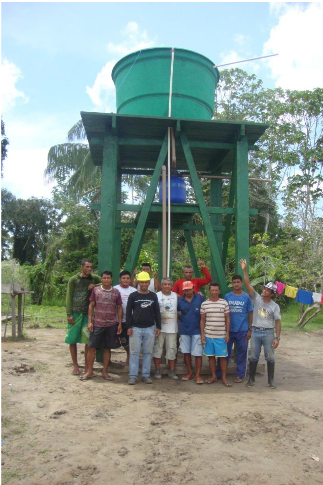
Figura 28: Moradores e técnicos do IDSM reunidos: satisfação com a instalação do sistema
