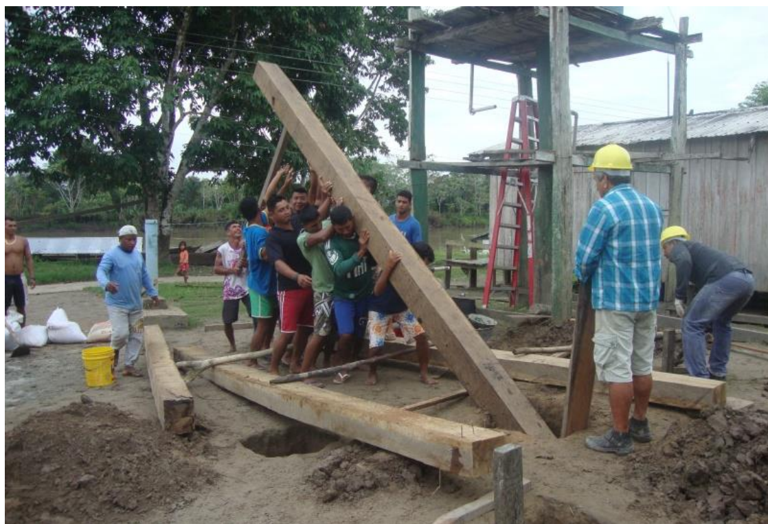
Figura 23: Esforço coletivo dos moradores para instalação da torre de apoio da caixa d'água
