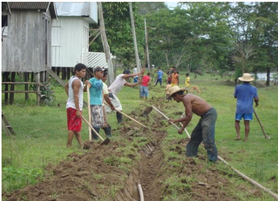
Figura 24: Abertura do canal para instalação da rede de distribuição da água na comunidade
