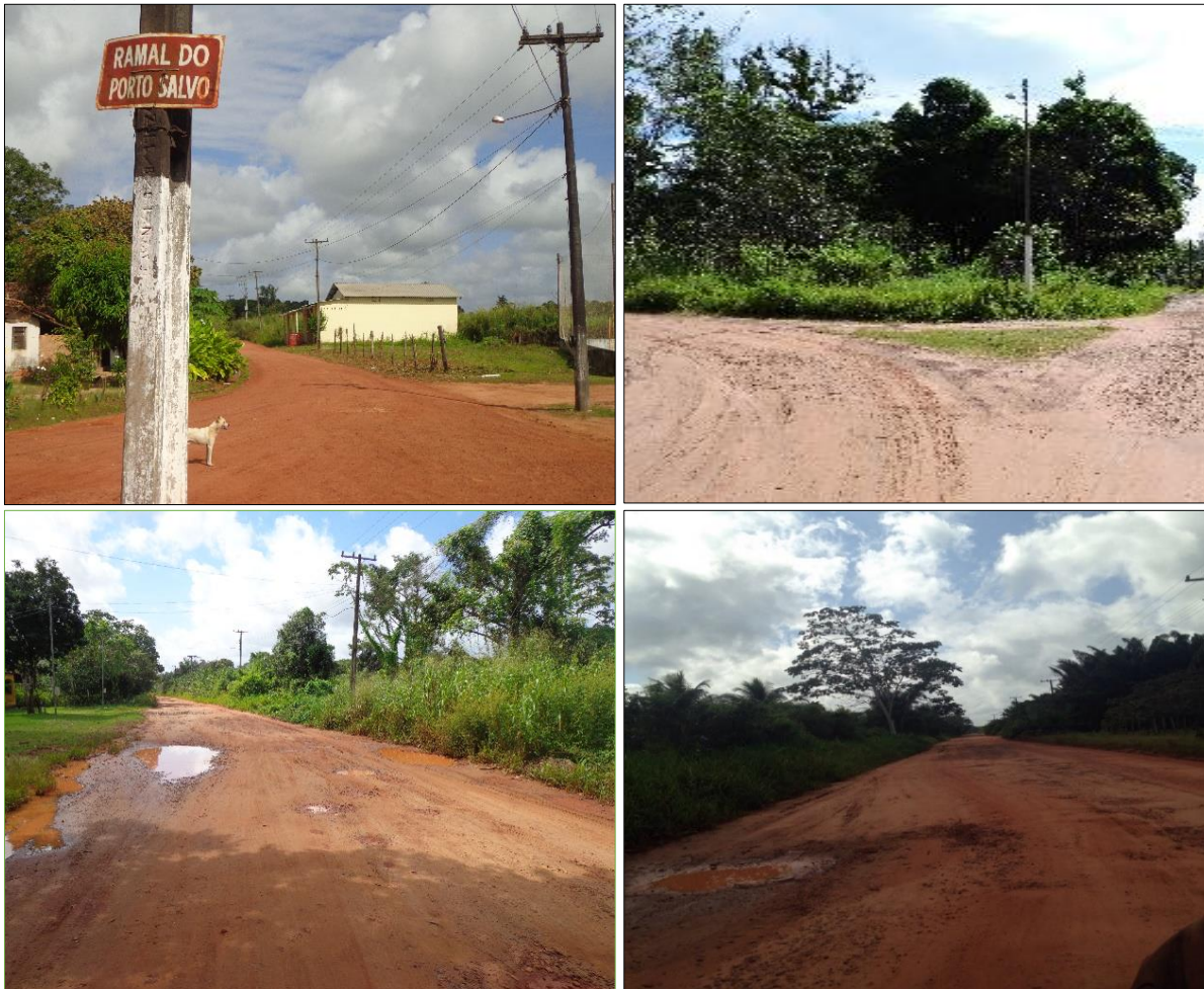
Fotografia 10: Vias públicas precárias
