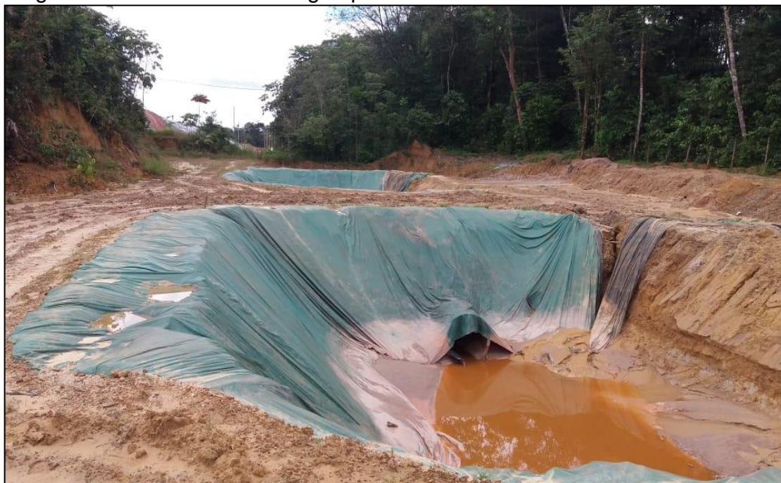
Figura 28: Canaletas de da água pluvial na base do Aterro em Marituba/PA.
