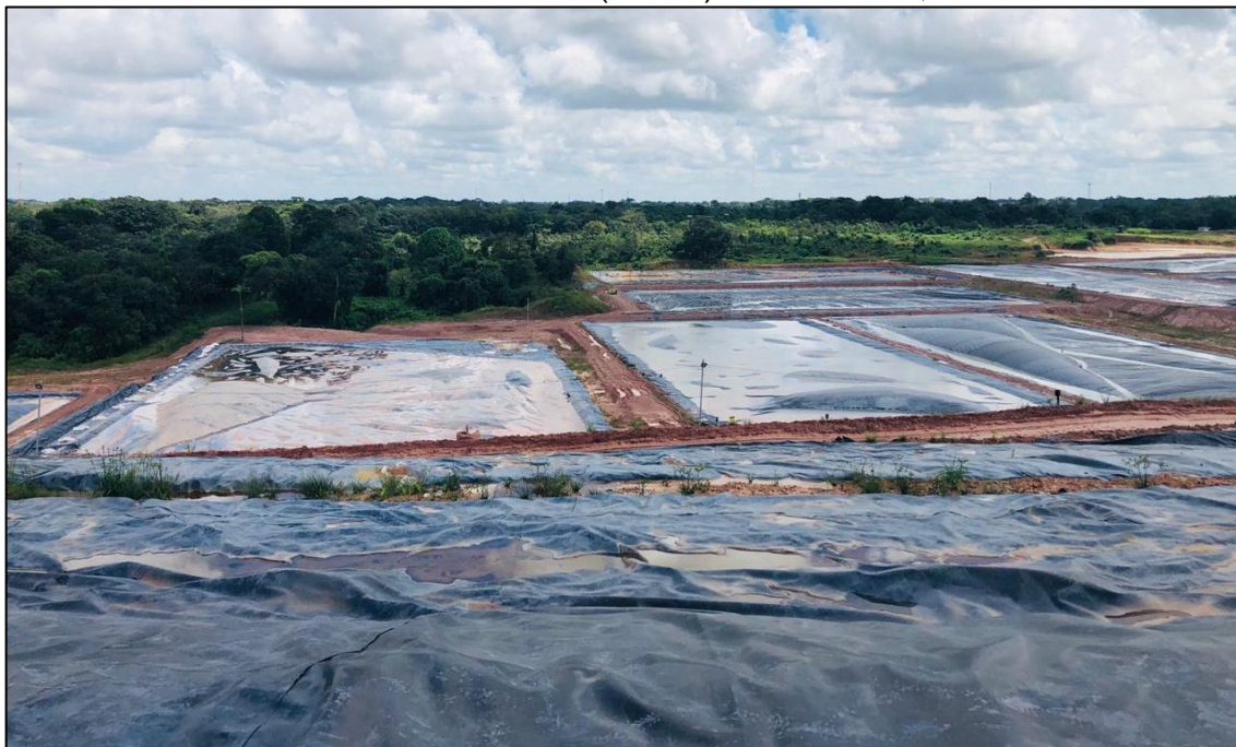
Figura 9: Lagoas de deposição de chorume da Central de Processamento e Tratamento de Resíduos Urbanos (CPTR) em Marituba, Estado do Pará.
