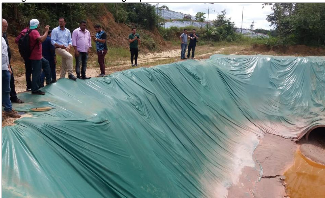
Figura 29: Canaletas da água pluvial na base do Aterro em Marituba/PA.
