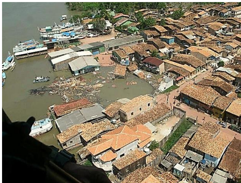
Figura 12 – Vista aérea do local do acidente no bairro de São João em Abaetetuba/PA.
