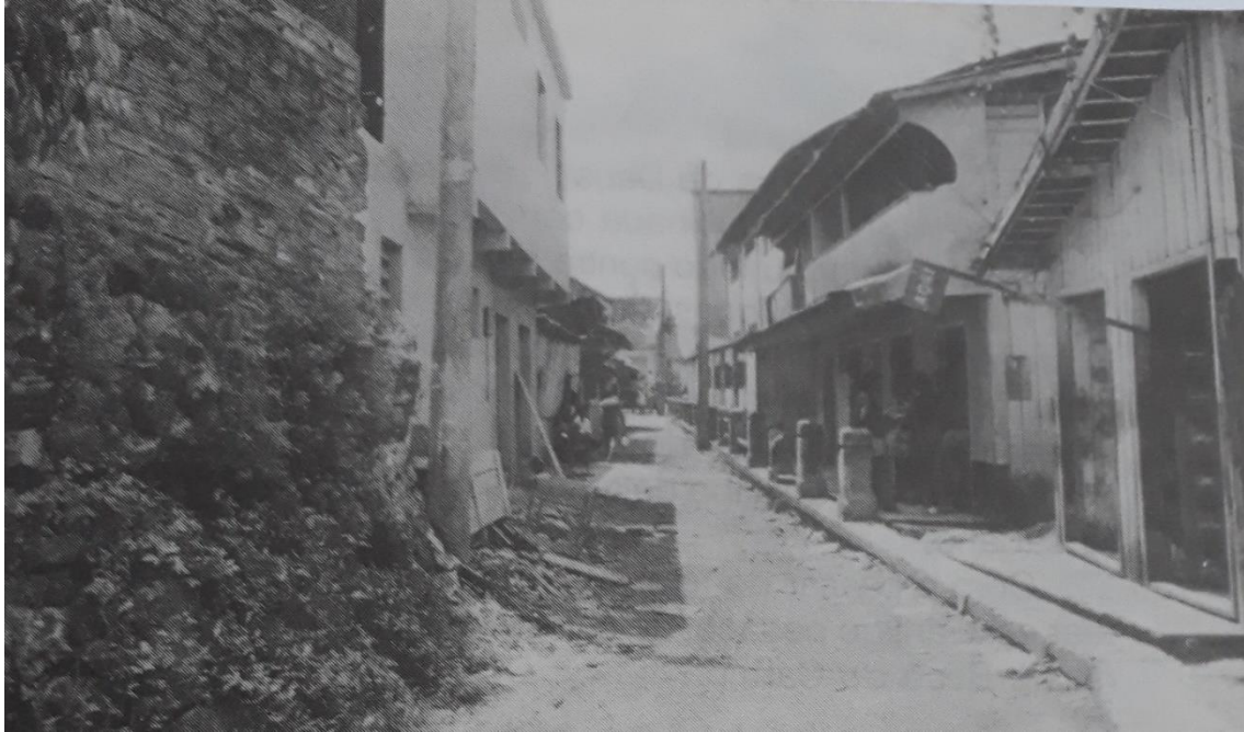
Figura 8: Beco do Carmo na década de 1990. À esquerda, o muro de pedras do Colégio Salesiano do Carmo ilustra a época quando servia de muro de arrimo para o rio. À direita, ainda existiam as pilastras do antigo guarda-corpo do cais. Ao fundo, vemos o Mercado do Porto do Sal. Fonte: Valente, José. A História nas Ruas de Belém: A Cidade Velha. Belém: CEJUP, 1993.
