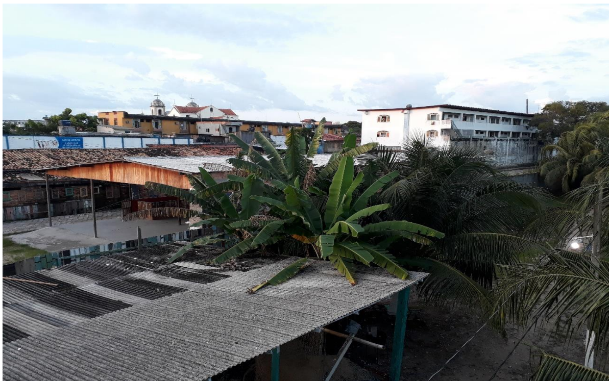
Figura 54: Volumes construídos. A foto, tirada do restaurante Na Maré, mostra os edifícios Palmeira e Colares, de altura semelhante à da Igreja do Carmo, destacando-se na paisagem. Um muro branco e azul separa o Porto Palmeira da comunidade do Porto do Sal. Fonte: Sabrina Campos, 27/06/18.
