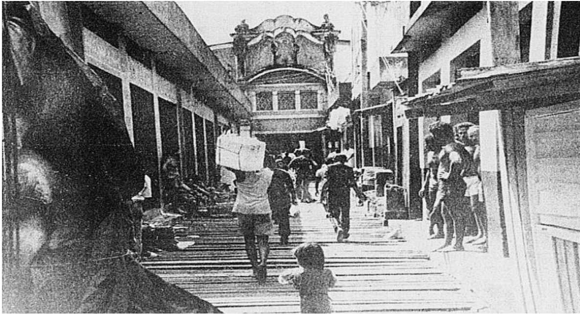
Figura 29: Características do mercado ao final da década de 1980. Apresentando sinais do tempo (escurecimento, manchas na pintura). O trapiche estava desnivelado, fechado nas laterais pelas construções, entre elas a Casa Macapá. À esquerda, postes em madeira convivem com barracas, a antiga estrutura do cais e outras construções. O comprimento deste trecho do trapiche parece corresponder ao da estrutura original. Fonte: Jornal O Liberal, 12/07/1989.
