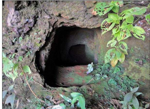
Figura 3. Túnel escavado na CECAV-SL-17: Túnel. Foto: André dos Santos (2011).
