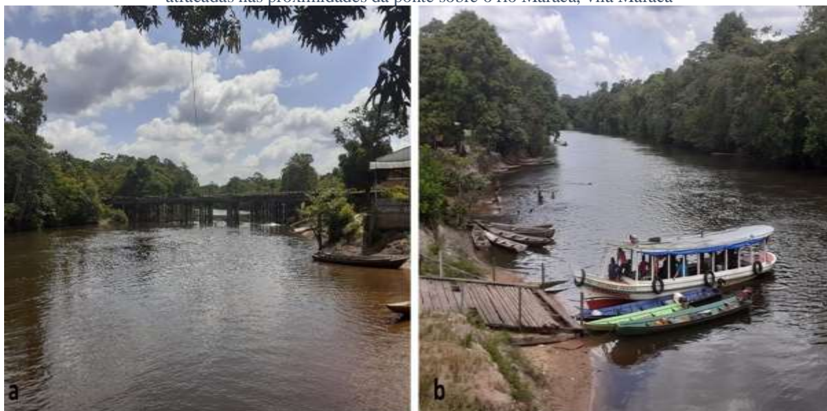
Imagem 7: a) Ponte sobre o rio Maracá, no encontro com a BR-156, vila Maracá; b) Embarcações regionais atracadas nas proximidades da ponte sobre o rio Maracá, vila Maracá
