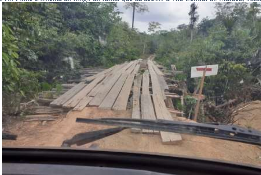
Fotografia 10: Ponte existente ao longo do ramal que dá acesso à vila Central do Maracá, outubro de 2019
