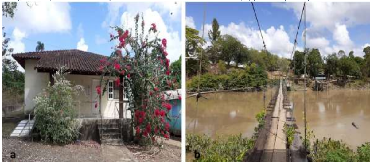
Imagem 52: a) Base construída pelo ICMBIO na entrada da vila Cunani; b) ponte suspensa que dá acesso à vila
