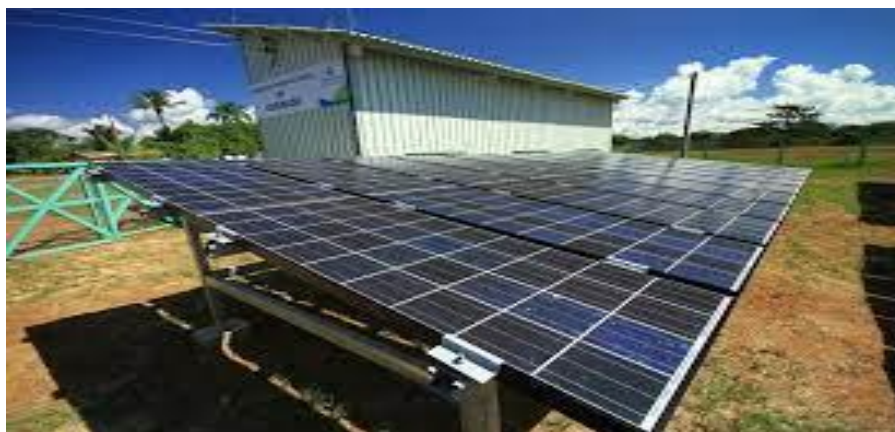
Figura 2.2 - Abastecimento de água município de Barreirinha, AM. Fonte - ANEEL (2021).
