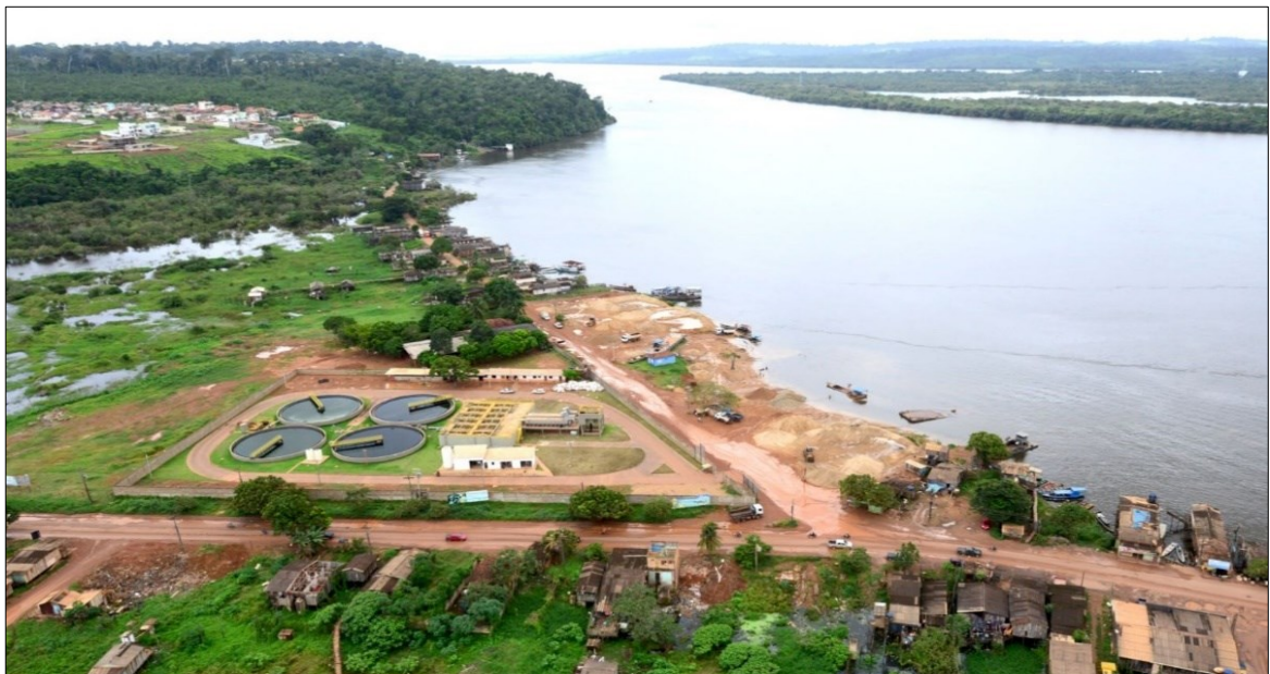
Figura 9 - Estação de tratamento de esgoto de Altamira-PA Fonte: Santos (2016).
