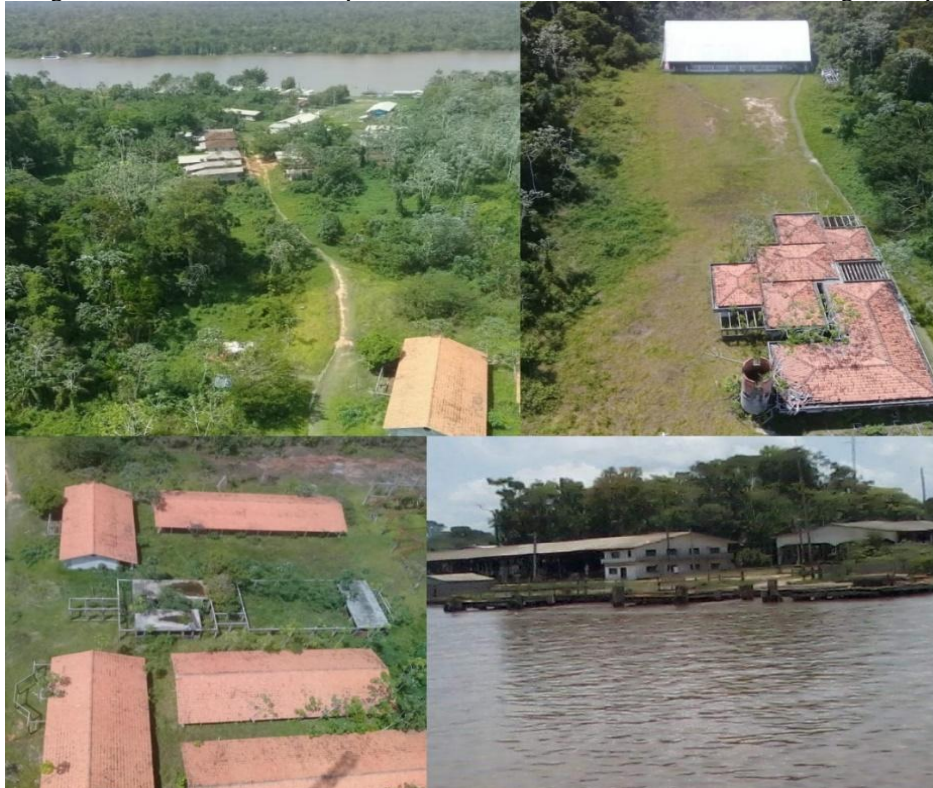
Figura 32 – Imagens de obras estruturantes paralisadas na Vila Mainardi: creche, escola e ginásio poliesportivo
