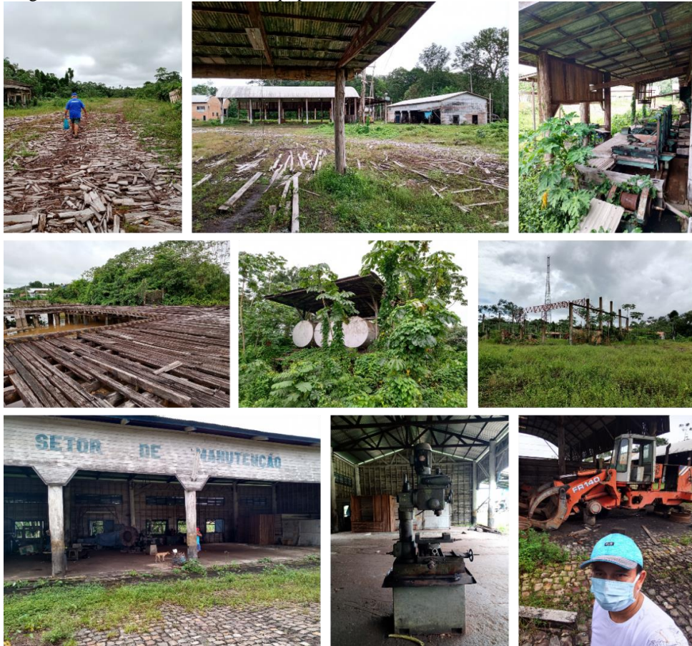
Figura 31 – Estruturas, setores e equipamentos de serrarias sucateados na Vila Mainardi
