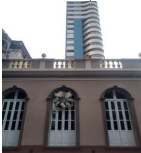
Figura 19: Fachada do casarão incorporado ao edifício Terrazos.
