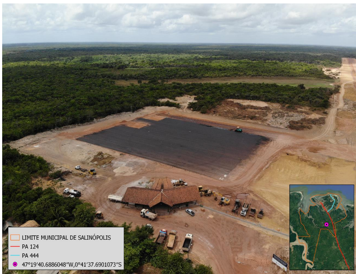
Figura 21: Obras do aeroporto de Salinópolis Fonte: Trabalho de campo realizado em outubro de 2019.
