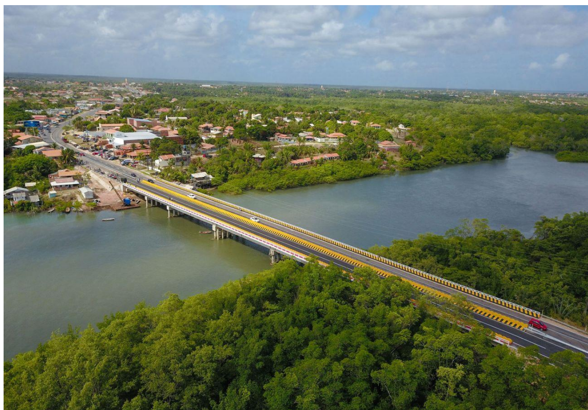
Figura 19: Obra de duplicação da PA 444 finalizada. Fonte: AGÊNCIA PARÁ (2019)
