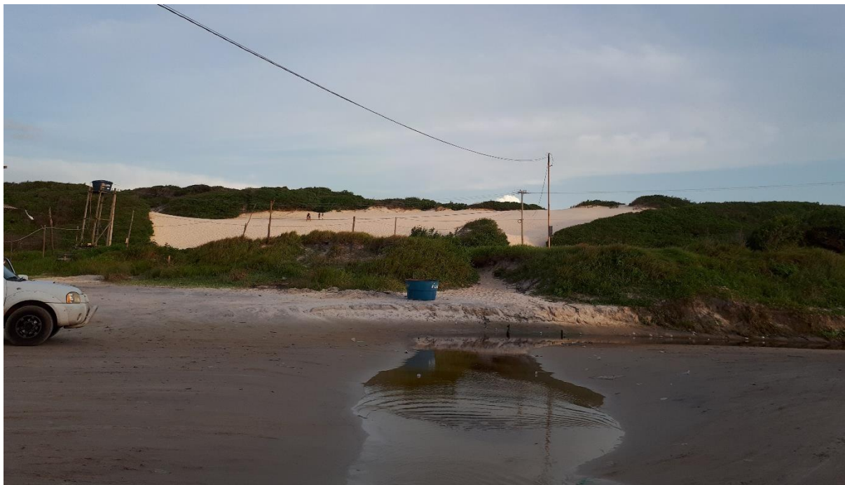
Figuras 16: Infraestrutura inadequada na praia do Atalaia. Fonte: Trabalho de campo realizado em junho de 2018.
