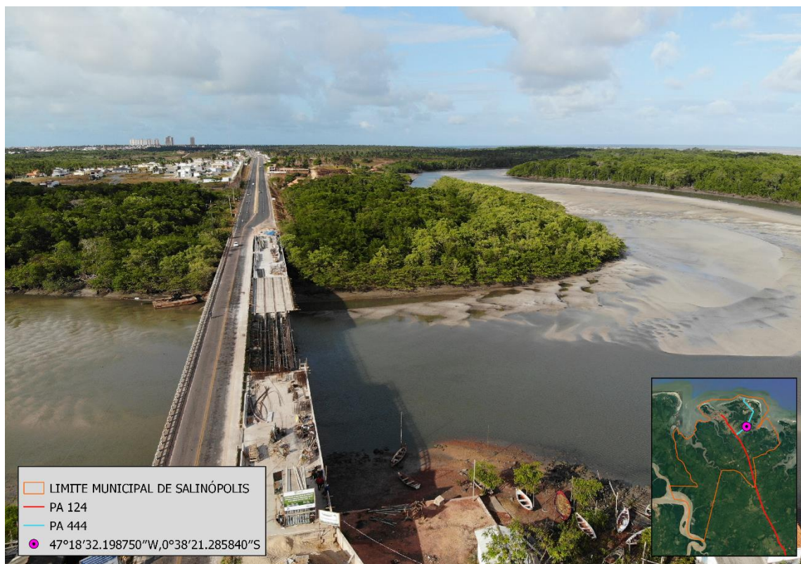
Figura 18: Andamento da obra de duplicação da PA 444 e da ponte sobre o rio Sampaio. Fonte: Trabalho de campo realizado em outubro de 2019.
