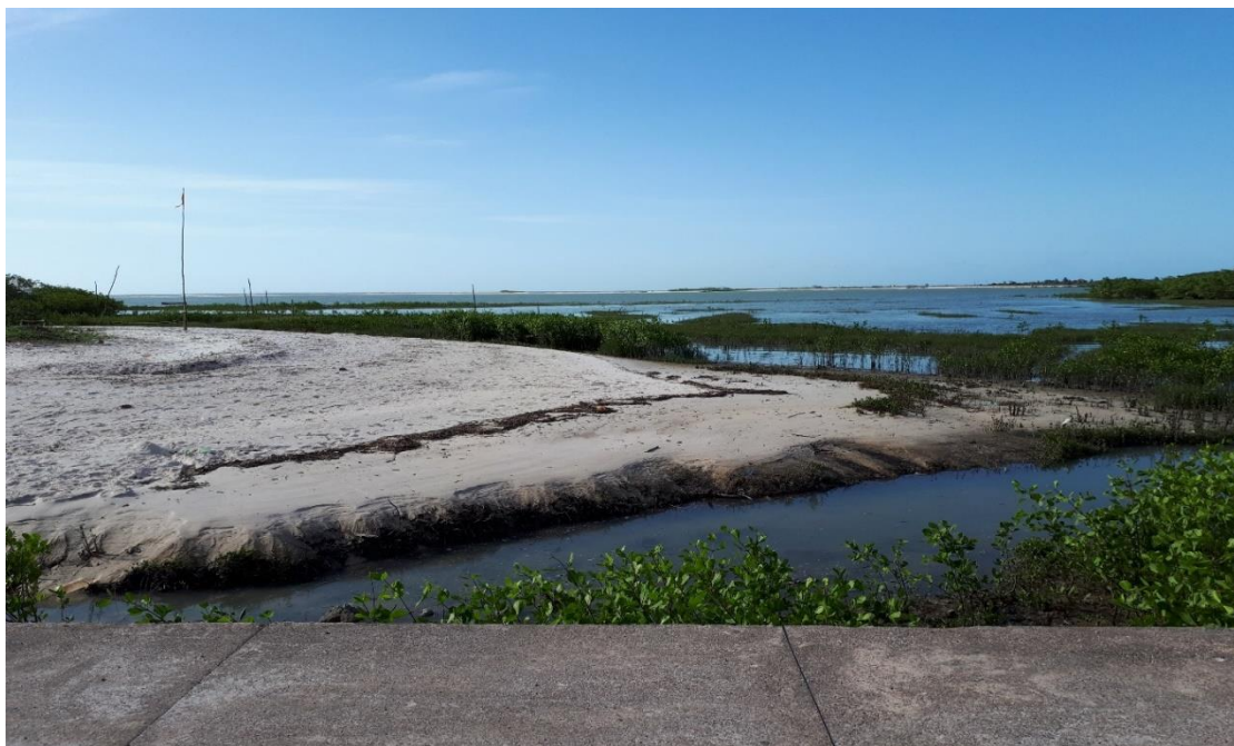
Figura 11: Formação de praia na área de segunda residência. Fonte: Trabalho de campo realizado em junho de 2018.
