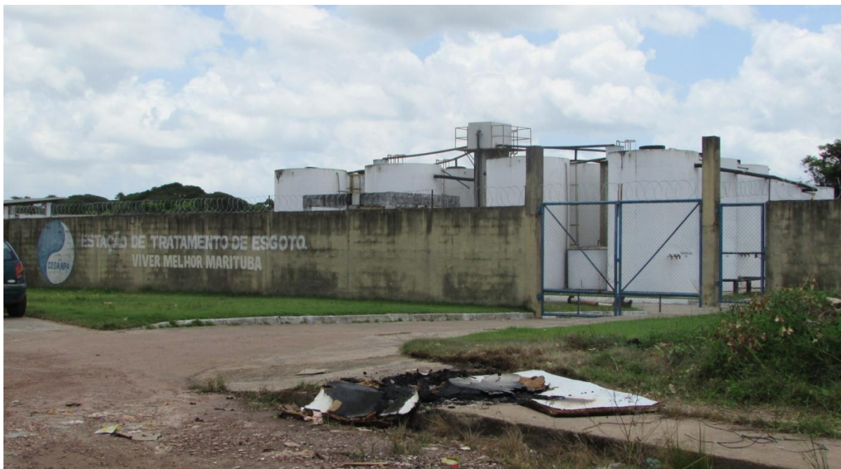
Foto 9. Marituba – Complexo Viver Marituba - detalhe da Estação de Tratamento de Esgoto (ETE). 2021
