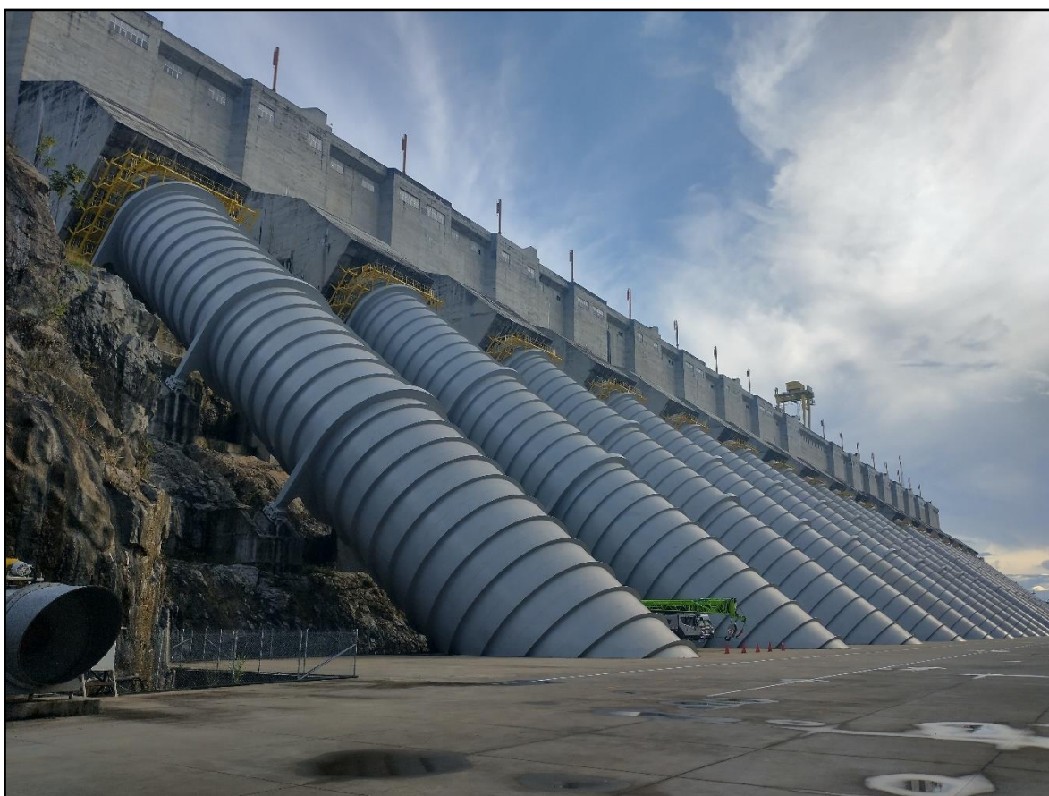
Figura 12 – Conduto forçado. Panorama do complexo sistema de engenharia possível no período técnico-científico-informacional.
