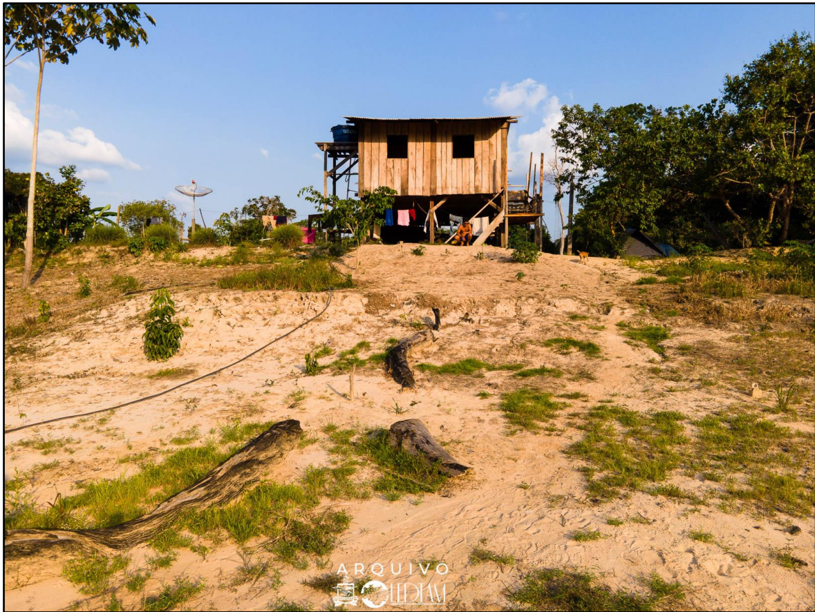
Figura 8 – Fotografia da estrutura de habitação do pescador-ribeirinho.
