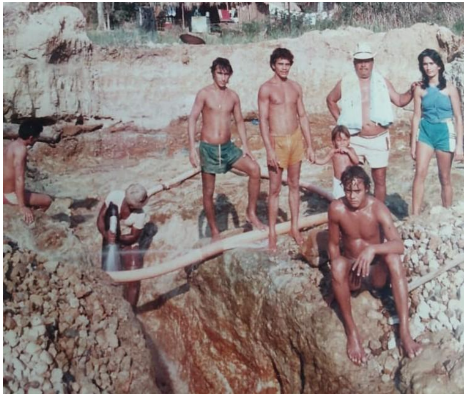
Figura 8- Trabalho com Chupadeira no garimpo da Ressaca em 1987
