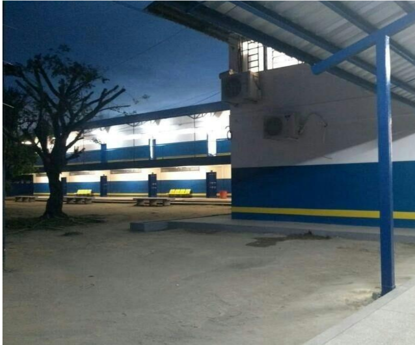
Figura 6: Foto estrutura da Escola
