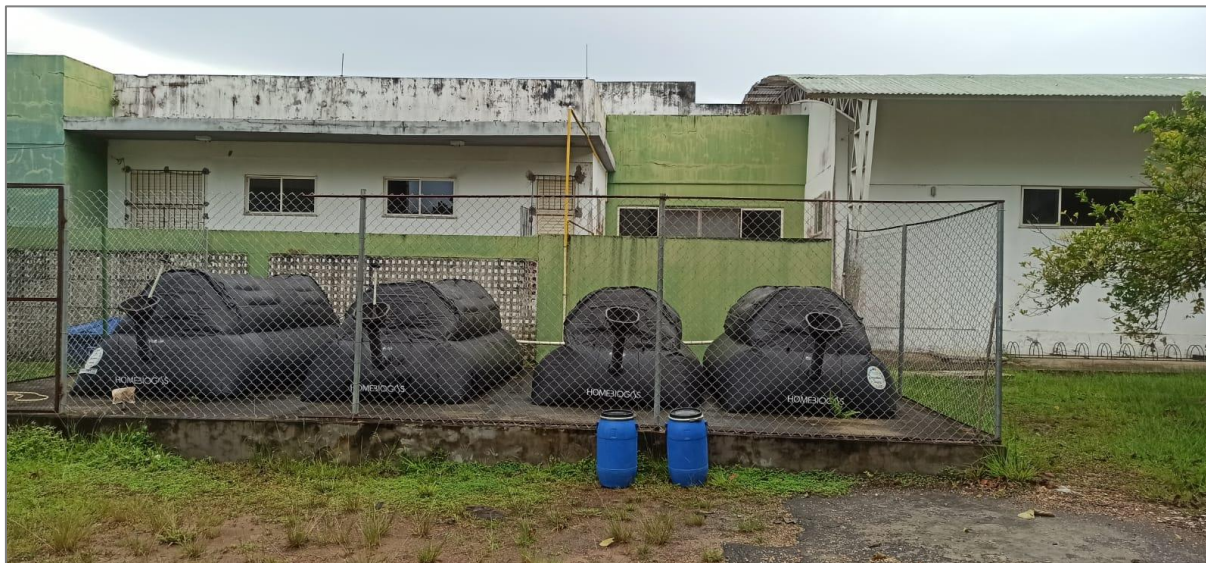
Fotografia 1: Projeto de aproveitamento do biogás resultante da compostagem dos resíduos orgânicos do restaurante universitário da UFRA.
