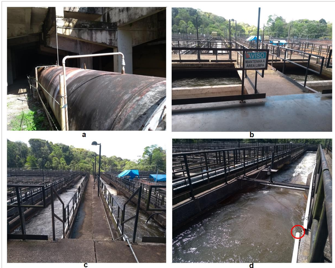
Figura 9 – Ponto de aplicação do coagulante – PAC (a), câmara de chegada (b), calhas Parshall (c) e ponto de aplicação do polímero de poliácridamida (d). Fonte: Chaves, 2020.
