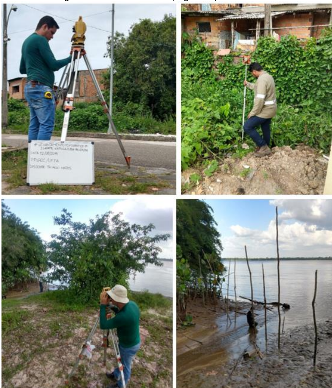
Figura 10: Levantamento topográfico planialtimétrico.
