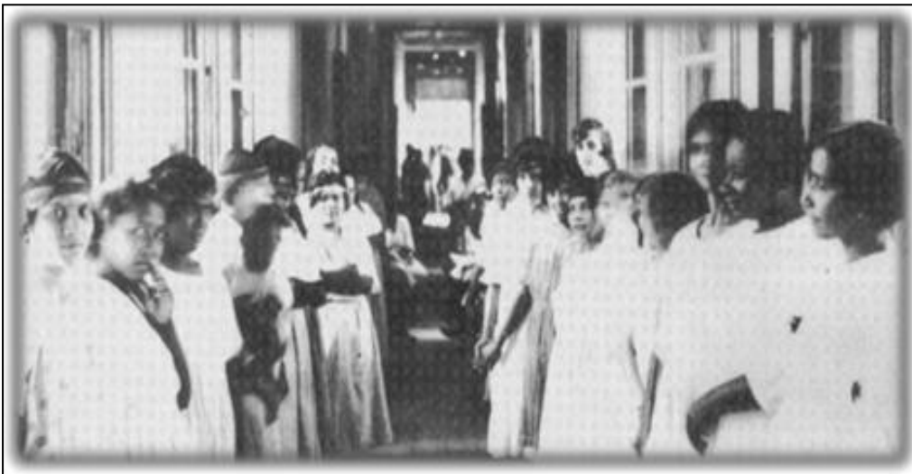
Fotografia8 - Asilo das Madalenas. Fonte: www.ebah.com.br . Acesso em 2016.
