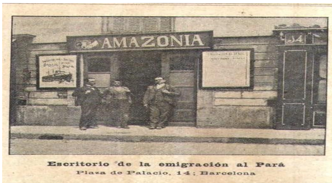
Figura 1- Escritório de imigração ao Pará – Plaza de Palacio, 14; Barcelona. 21
