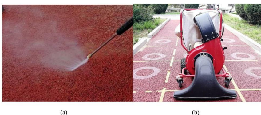
Figura 18. Equipamentos para limpeza: (a) Lavadora de alta pressão; (b) equipamento de sucção a vácuo.
