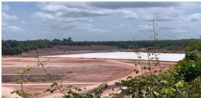
Figura 6 – Lagoa de depósito do resíduo do beneficiamento do caulim.
