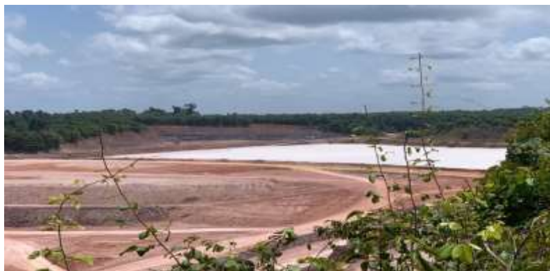
Figura 12 – Lagoa de depósito do resíduo do beneficiamento do caulim.
