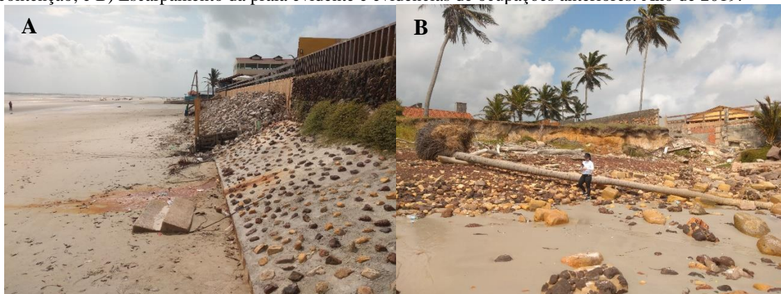
Figura 5 - Área localizada na Praia do Farol Velho com características de erosão severa. A) Presença de estruturas de contenção; e B) Escarpamento da praia evidente e evidências de ocupações anteriores. Ano de 2019.
