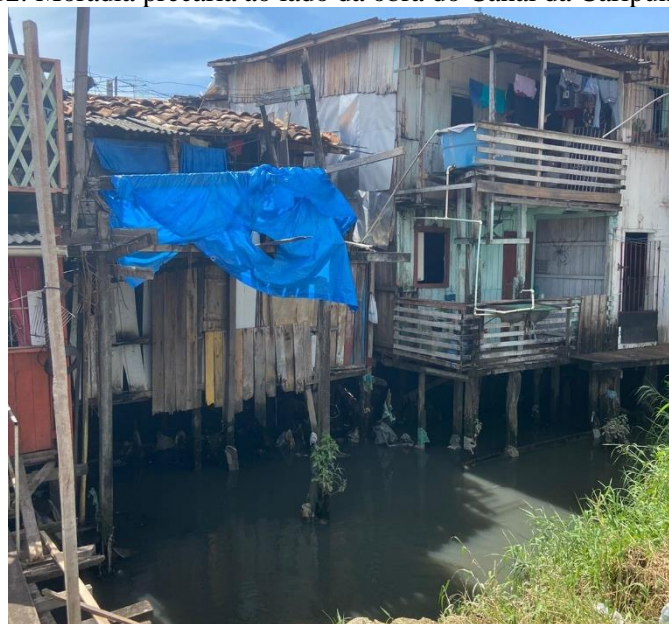
Figura 12: Moradia precária ao lado da obra do Canal da Caripunas.
