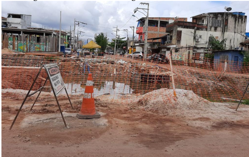
Figura 5: Obras de macrodrenagem no Canal dos Timbiras.
