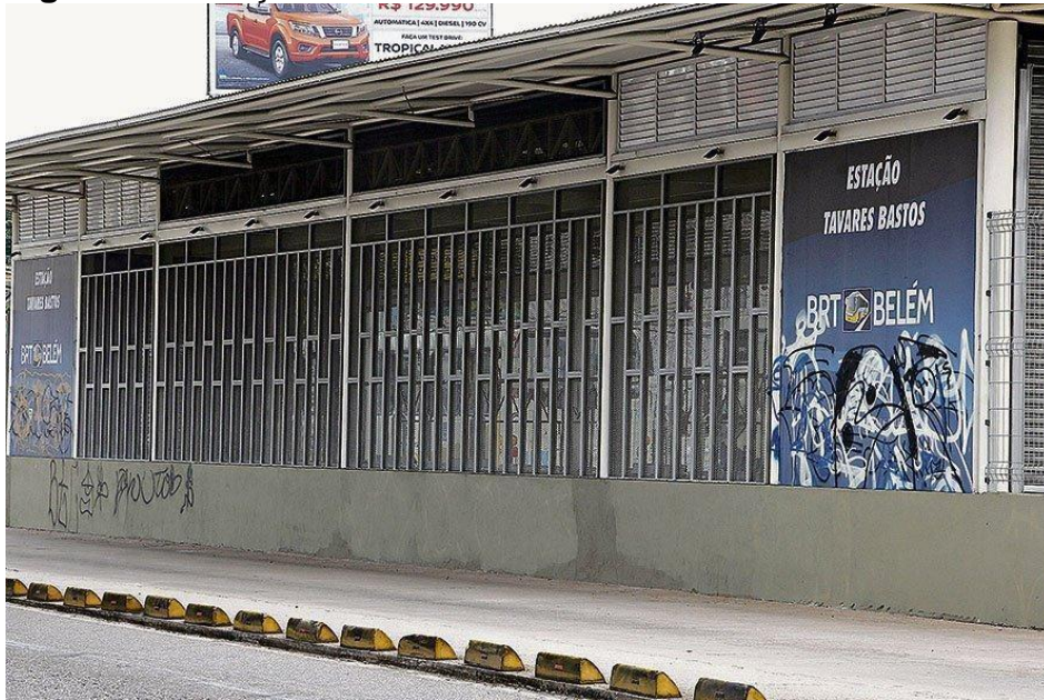
Figura 9 – Estação BRT Tavares Bastos
