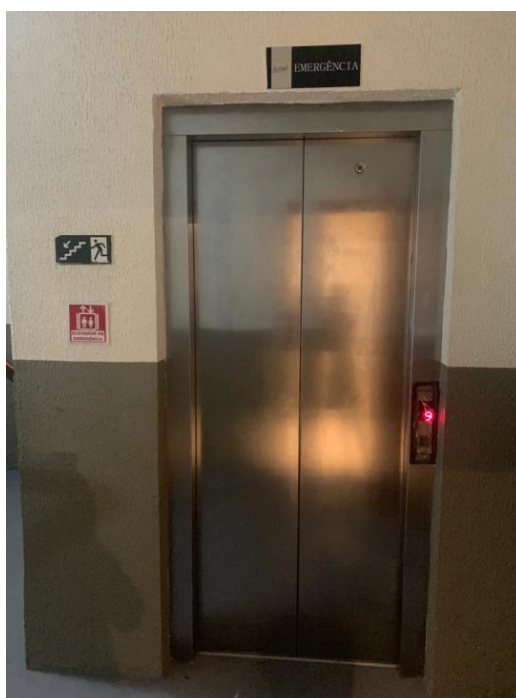
Figura 9 – Elevador de emergência do edifício B
