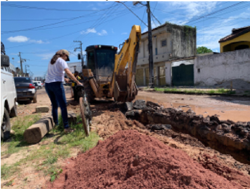
Figura 3 – Visita à Obra de Macro drenagem na Celso Malcher
